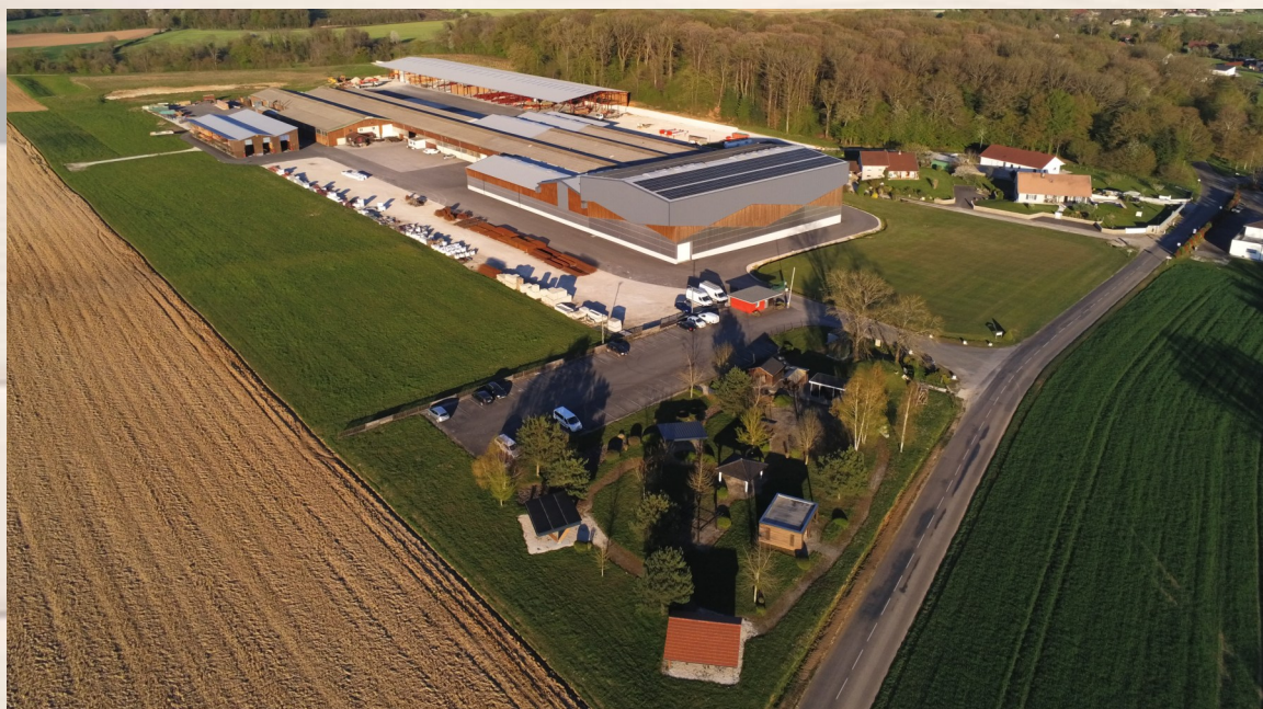
SITE DE FABRICATION
